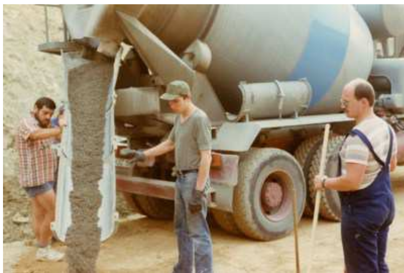
das erste Betonauto
